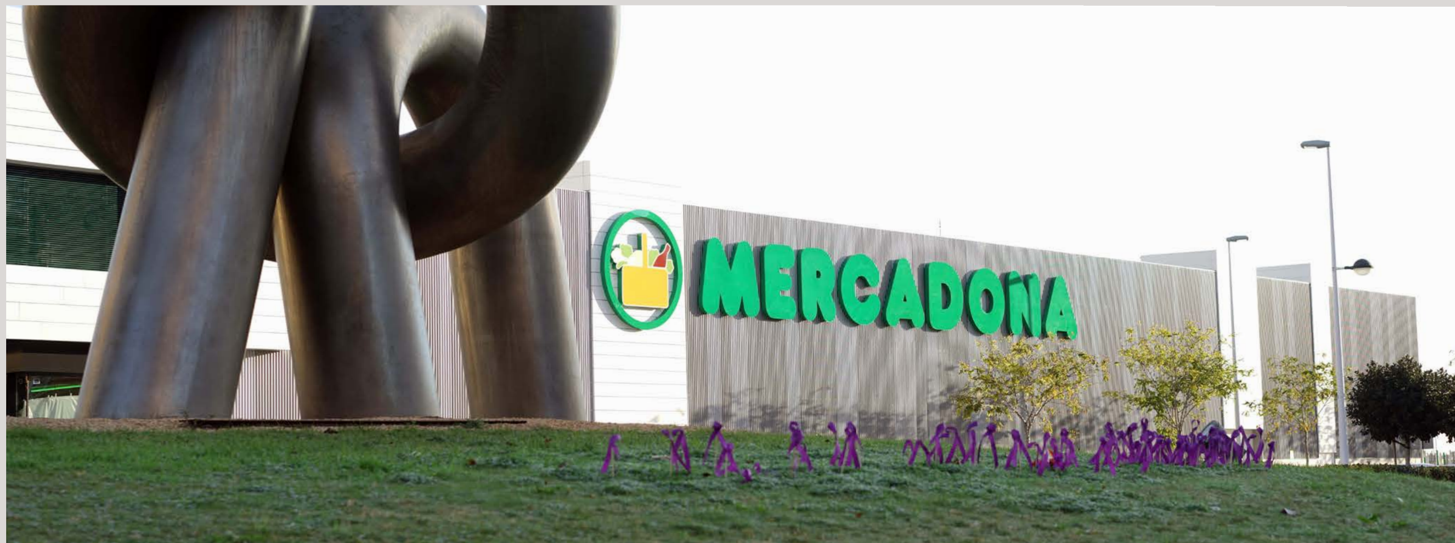
Façana del supermercat de Periodista Azzati al Port de Sagunt, València.
