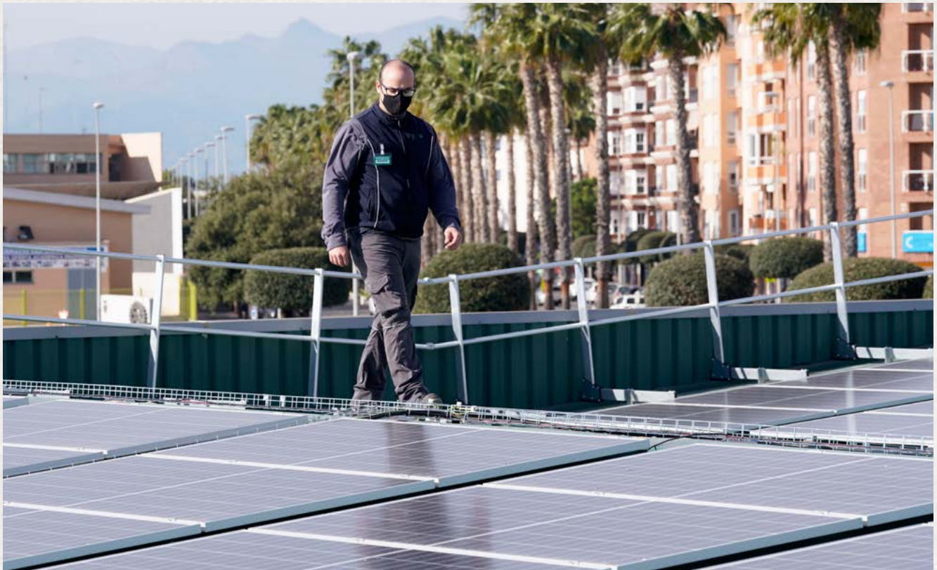
Álvaro, treballador del supermercat de Novenes a Borriana, Castelló.
