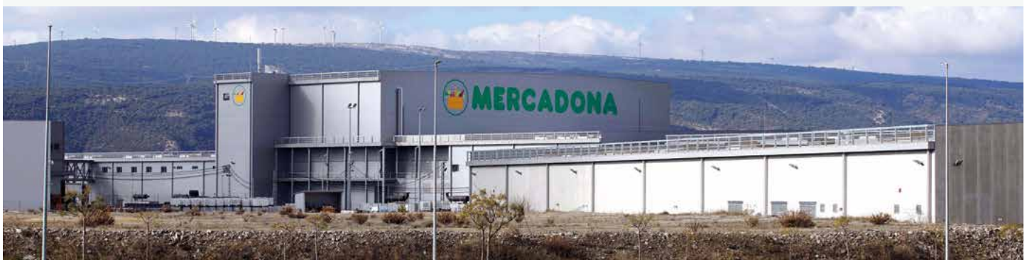
Bloc logístic de Vitòria-Gasteiz, Araba/Àlaba, en construcció.
