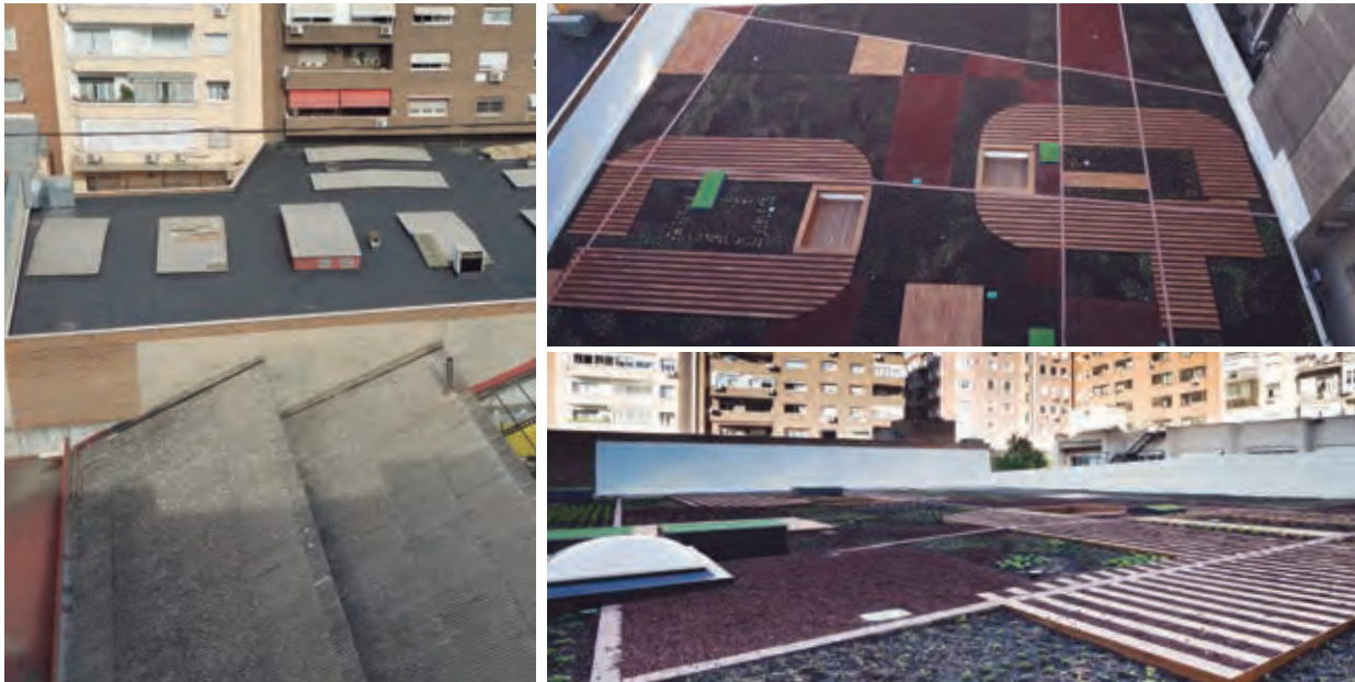
Imatges de l'abans i el després del jardí de la coberta del supermercat de Paseo General Martínez Campos a Madrid, ubicat en un pati d'illa de cases.
