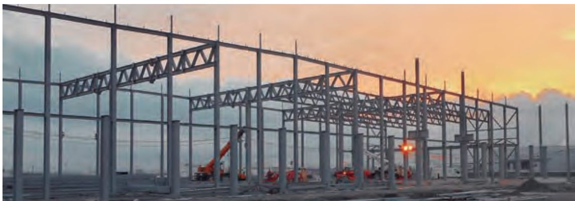
Obres del bloc logístic de Vitòria-Gasteiz (Araba/Àlaba).
