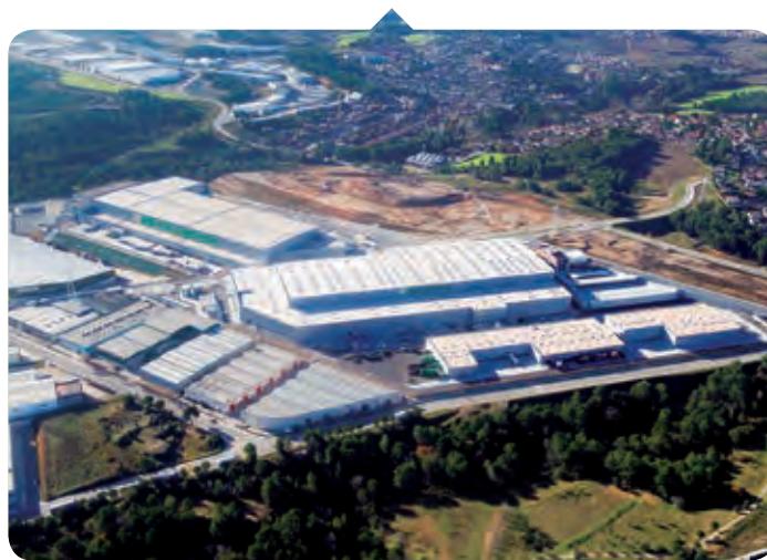
Obres del bloc logístic d'Abrera, Barcelona.
