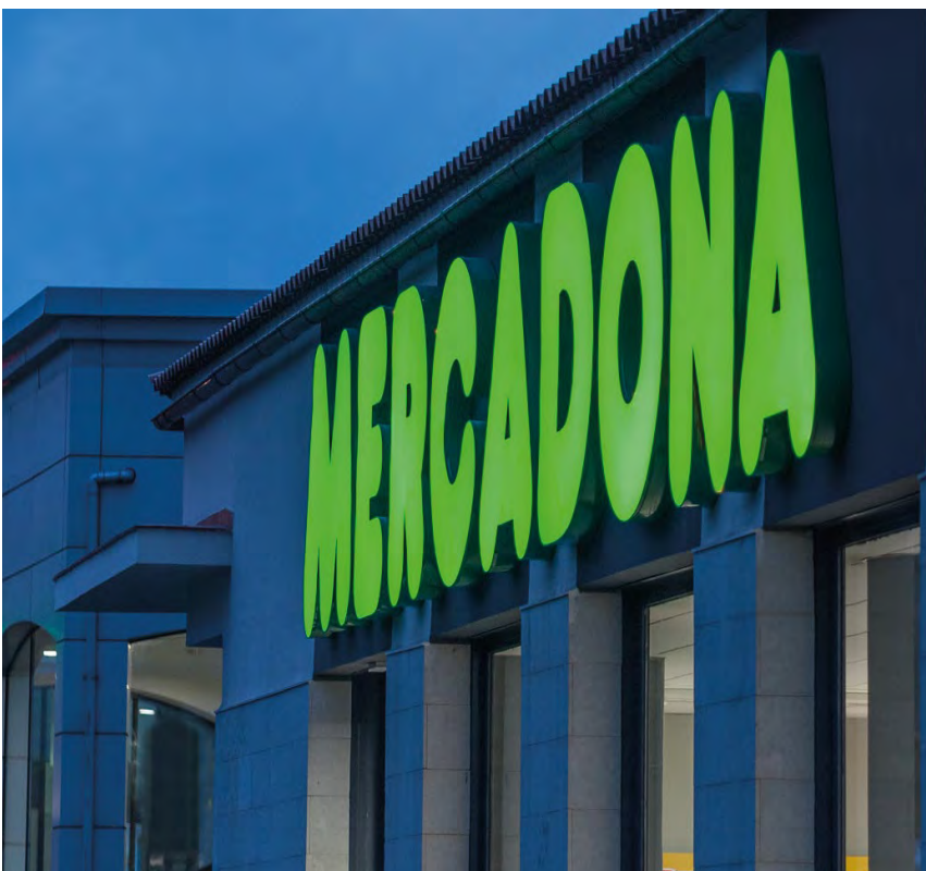
Fachada do supermercado de Tacoronte, Santa Cruz de Tenerife.
