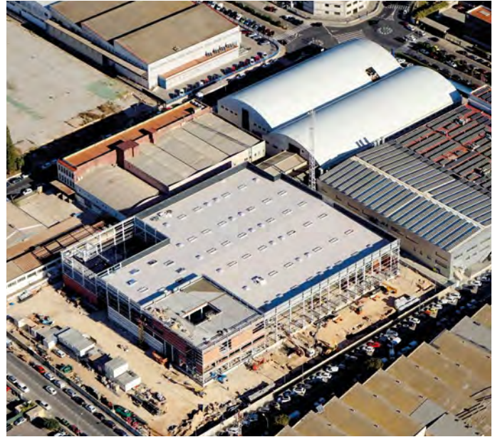
Fotografía aérea das obras de construción do futuro centro de distribución de compra en liña no polígono Vara de Quart, Valencia.
