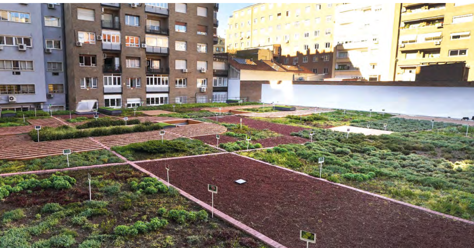
Xardín da cuberta do supermercado do Paseo General Martínez Campos en Madrid, situado nun patio dun bloque de edificios.
