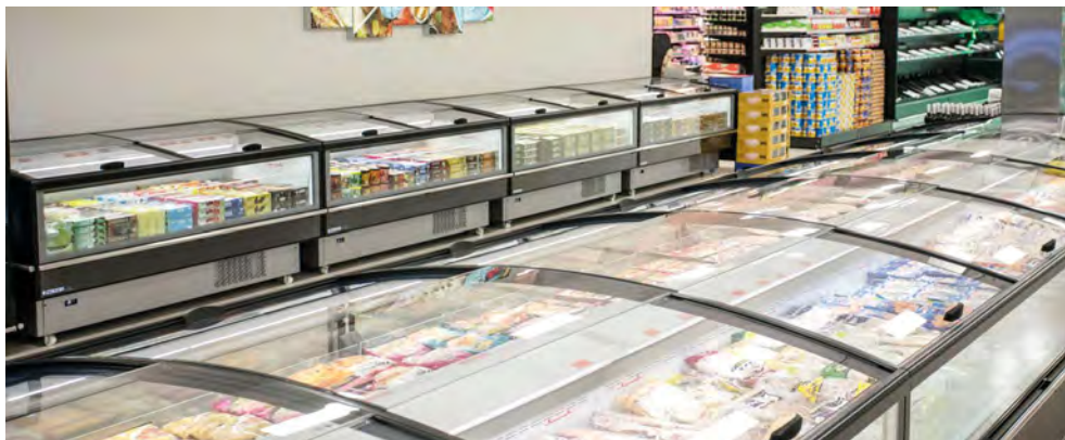
Sección de conxelados do supermercado de Peligros, Granada
