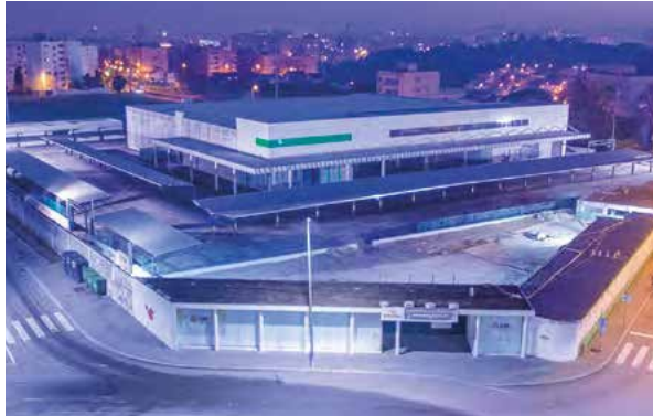
Supermercado en construción en Canidelo, Vila Nova de Gaia, Porto.
