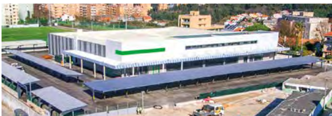
Exterior do supermercado en construción de Canidelo, Vila Nova de Gaia, Porto.
