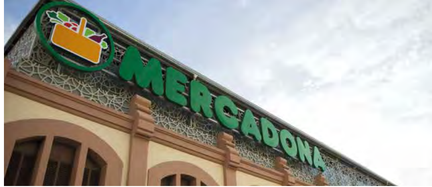
Fachada do supermercado da rúa Carlos V na Cidade Autónoma de Melilla.
