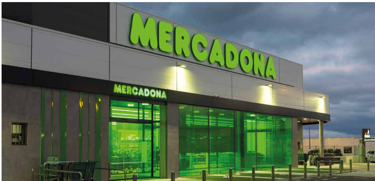
Fachada do supermercado de La Almadraba na Cidade Autónoma de Ceuta.
