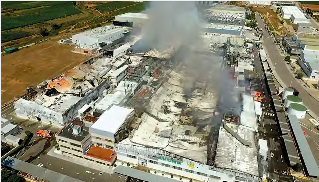
Instalacións da fábrica de pans e tortas Forvasa en Puçol, València, afectadas polo incendio.
