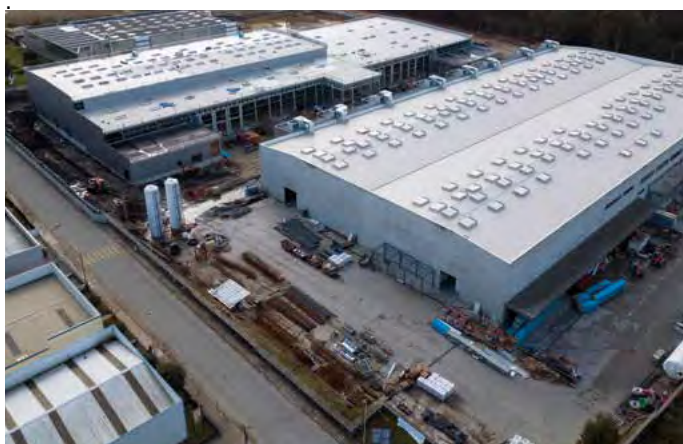
Fotografía aérea da construción do bloque loxístico na Póvoa de Varzim, Porto.
