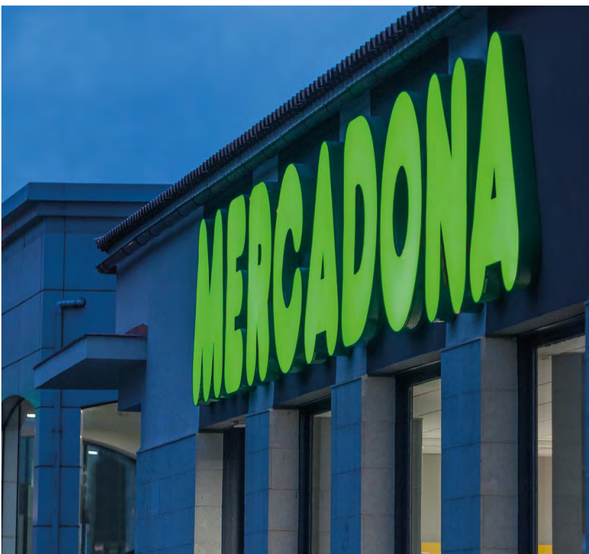
Fachada del supermercado de Tacoronte, Santa Cruz de Tenerife.
