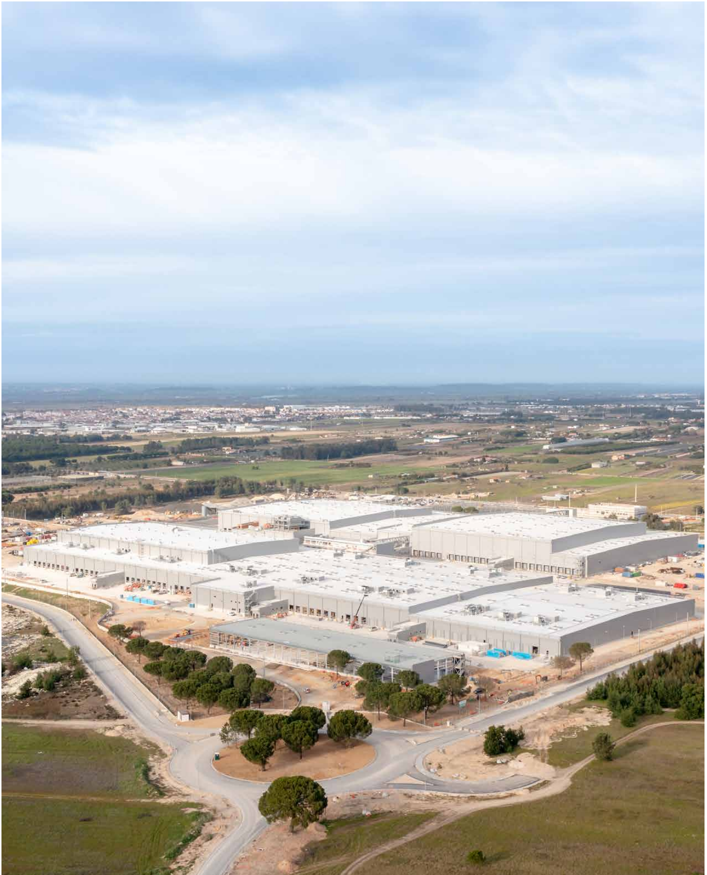
Vista aèria del bloc logístic d'Almeirim, Santarém, en construcció.
