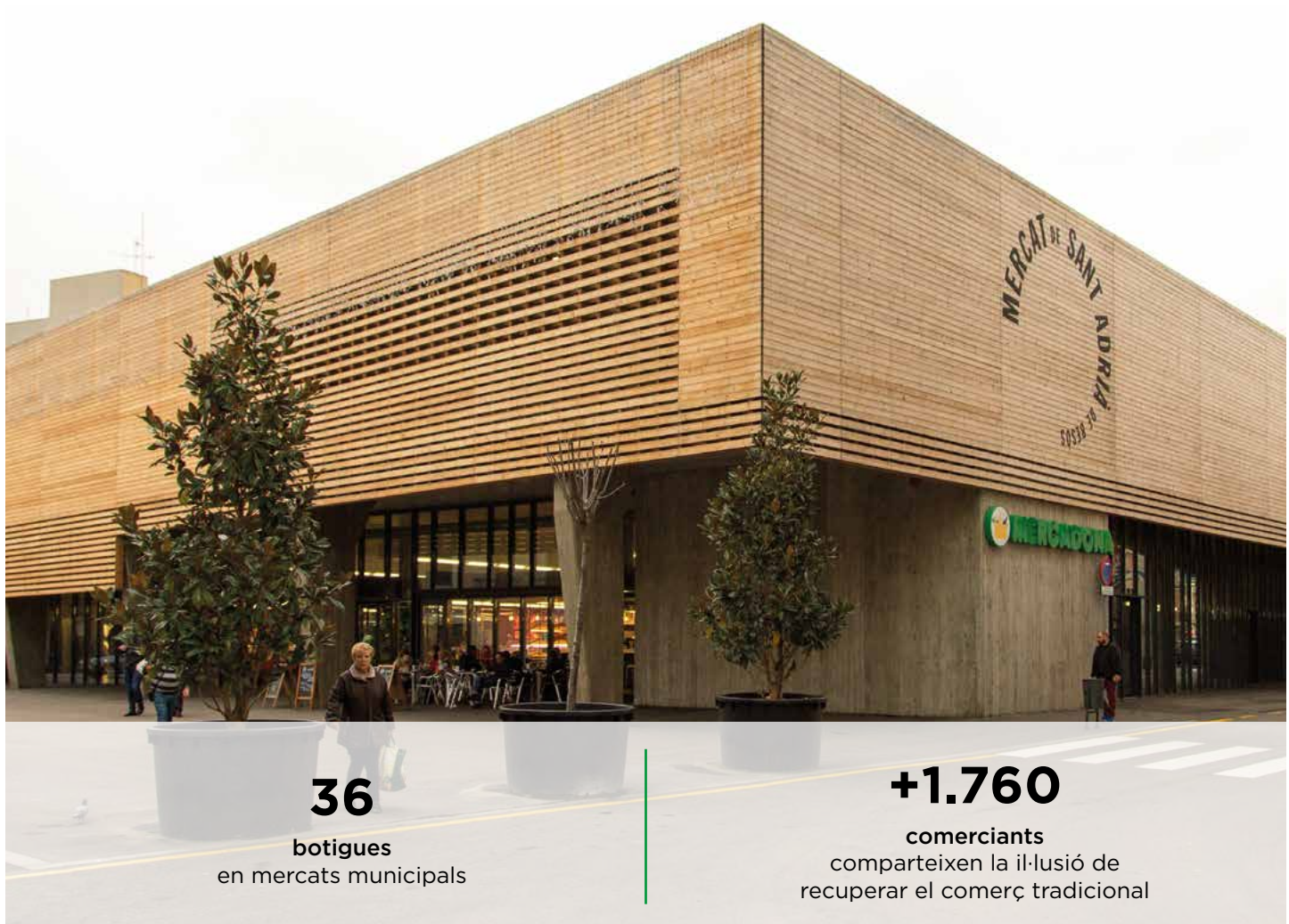
Façana del supermercat al Mercat Municipal de Sant Adrià de Besòs, Barcelona.
